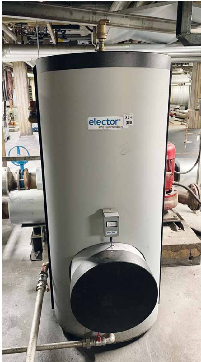
Teollisuuden asiakkaalle on asennettu isoon lämmitysjärjestelmään elector-vedenkäsittelylaite
