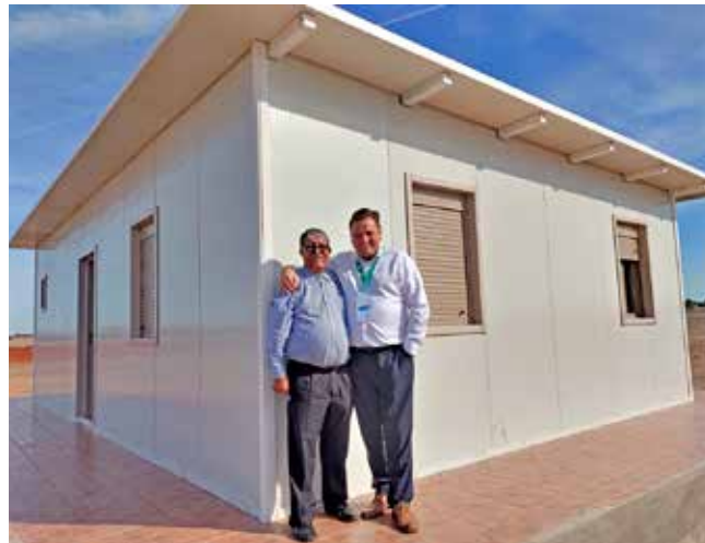
Valmis rakennus verhoillaan rakennuslevyillä, jolloin saavutetaan riittävät palonkesto-ominaisuudet sekä UV-säteilyn kesto.
