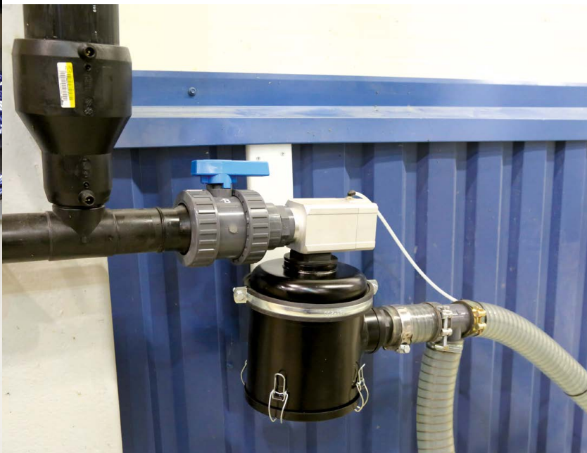
Vasemalla Atlas Copcon ja Fluorotechnin Aikololle toimittama alipainepumppu sekä putkistojärjestelmä toimii mainiosti ja on pudottanut energiakuluja merkittävästi. Kuvassa ylhäällä kosteussuodattimella varustettu alipaineputkijärjestelmän haara.
