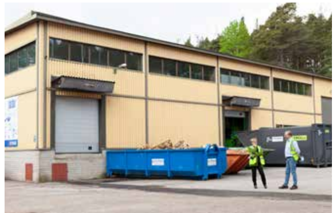
Ulospäin tehtaan muutostyöstä kertoo vain asfaltissa kulkeva raita, jonka alla lämpöputki kuljettaa tehtaan jalostetut hukkalämmöt asuin- ja kiinteistöjen lämmitykseen.
