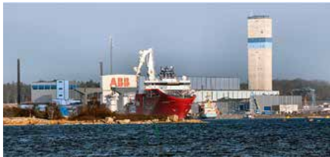
Kuva 368. ABB:n kaapelitehdas Karlskronassa, joka siirtyi NKT:n omistukseen. Korkean jäähdystornin alla sijaitsevat pystyyn asennetuilla kulmasuuttimilla varustetut ekstruuderit. Kun kaapelit ovat jäähtyneet tornissa, ne kelataan rullalle tai suoraan erikoisaluokseen, joka näkyy tehtaan edustalla. Joillain tällaisilla aluksilla on kapasiteettia kelata tuhansia kilometrejä kaapelia ilman että sitä tarvitsee jatkaa.
