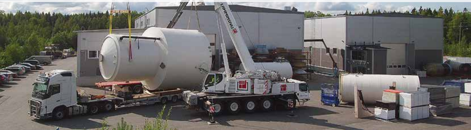
Suolahapon varastosäiliö varoaltaalla, PE-HD/lujitemuovi
