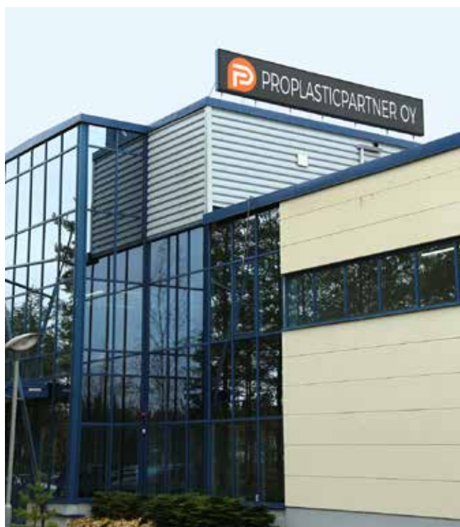
Uusi nimi jo komeilee tuttujen tilojen katolla
