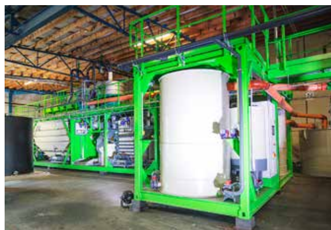
Osa pesulinjan suljetun vedenkierron vesienkäsittelyjärjestelmää
