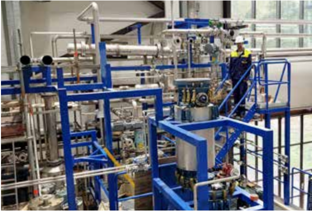
Prosessikemian pilotointialustan laiteasennukset ovat meneillään ja valmistuvat loppuuskysyllä.
